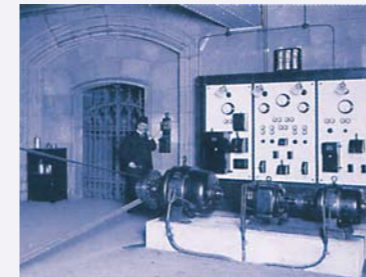
HEW installiert die modernste Läutemaschine im Kölner Dom. Die Maschine treibt präzise drei Glocken gleichzeitig an.
